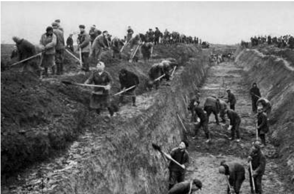
Строительство оборонительных сооружений под Москвой. Осень 1941 г.
