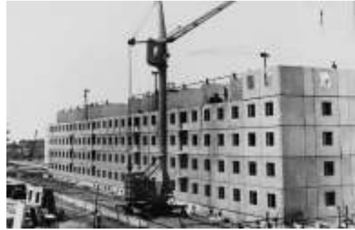
Строительство пятиэтажного жилого дома. Город Волжский
