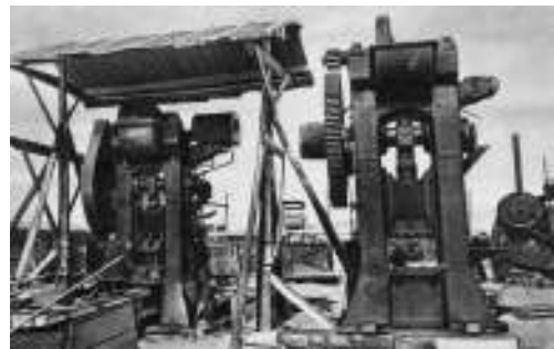
Монтаж оборудования на эвакуированном заводе. Казахстан. 1942 г.
