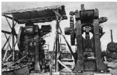
Монтаж оборудования на эвакуированном заводе. Казахстан. 1942 г.
