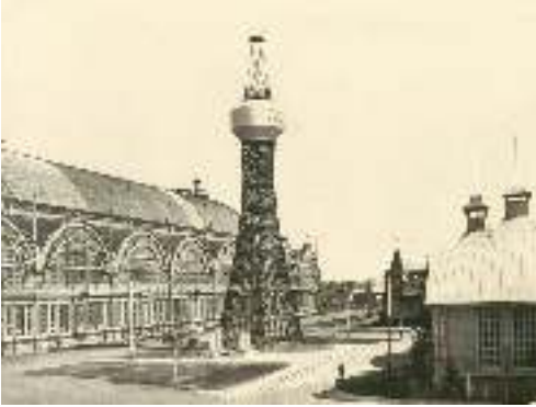
Гиперboloидная башня. Инженер В. Г. Шухов
