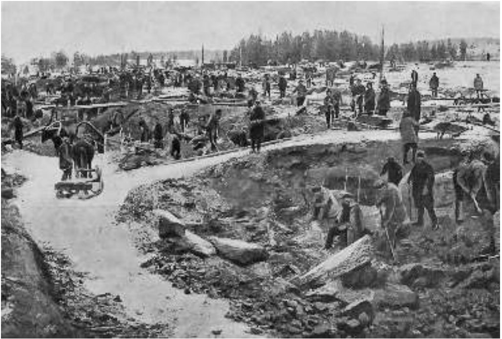
Строительство Беломорско-Балтийского канала, на котором применялся труд заключенных. Первая половина 1930-х годов
