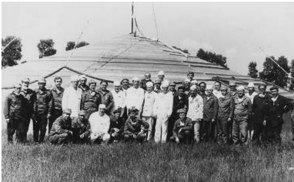
Группа ликвидаторов аварии на Чернобыльской АЭС. 1986 г.
