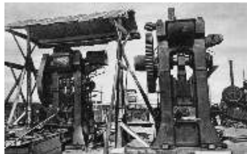
Монтаж оборудования на эвакуированном заводе. Казахстан. 1942 г.
