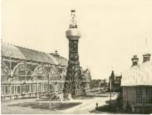
Гиперboloидная башня. Инженер В. Г. Шухов
