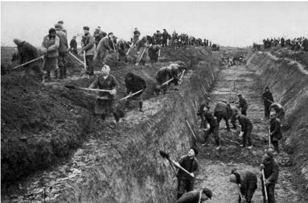
Строительство оборонительных сооружений под Москвой. Осень 1941 г.
