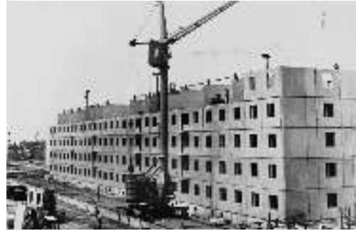
Строительство пятиэтажного жилого дома. Город Волжский
