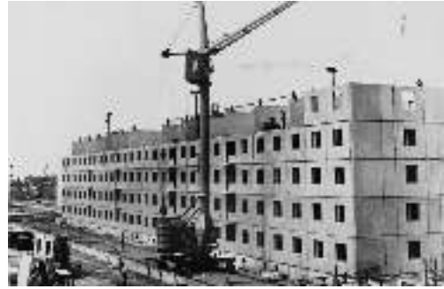
Строительство пятиэтажного жилого дома. Город Волжский
