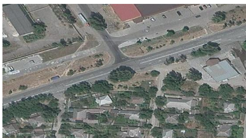
Рис. 2 – Пересечение проезжих частей: ул. Шоссейная и ул. Таганрогская
